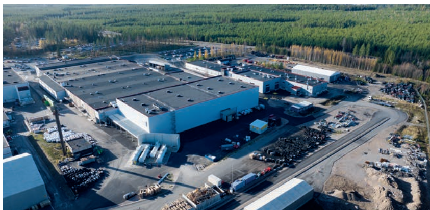
Zakład transmisyjny znajduje się pomiędzy centrum inżynieryjnym a zakładem montażowym. Przestrzenie zewnętrzne również zostały przeprojektowane, a dzięki nowej bramie północnej ruch ciężarówek wokół zakładu przekładni zmniejszył się o ponad połowę.
